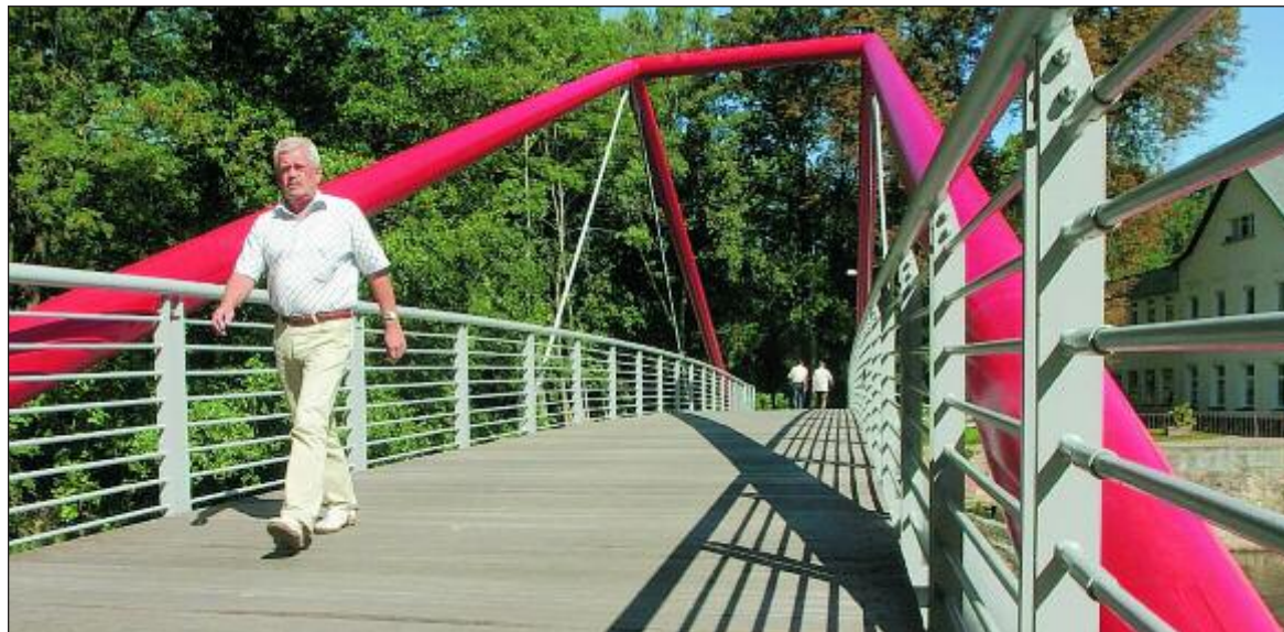
Die Brücke zwischen Straßburger und Beckerstraße ersetzt einen alten Überweg, der vom Hochwasser 2002 weggerissen wurde. Der Neubau kostete rund 500.000 Euro.
